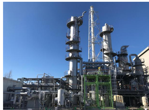
図 10 省エネ型 \text{CO}_2 回収設備 ESCAP ®
