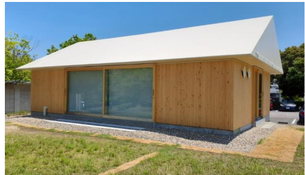
図3 DACシステム評価装置の概念図(上)と装置を設置したDAC実験棟(下:RITE敷地内)
