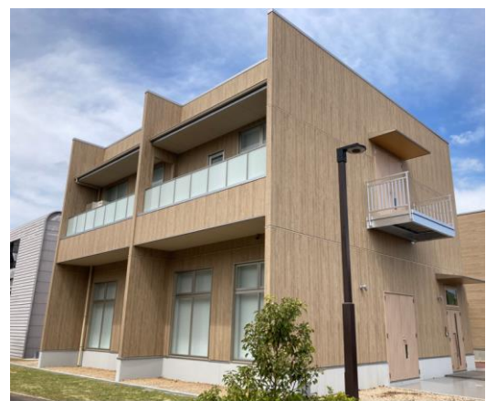
図 5 新設したバイオものづくり実験棟
