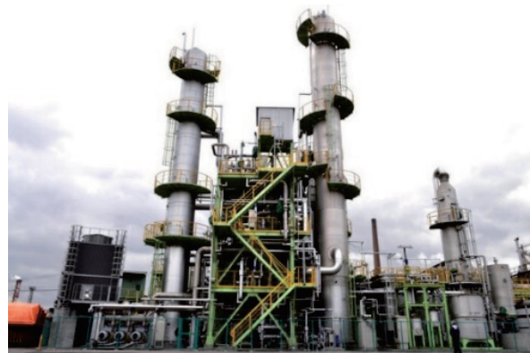
図3 炭酸ガス販売用商用化1号機（新日鉄住金(株)室蘭製鉄所内）
