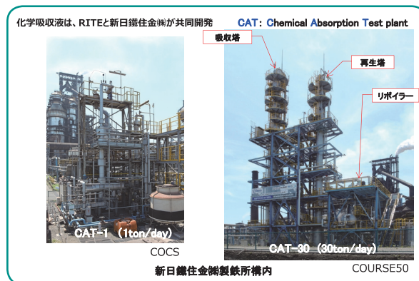
図2 パイロット試験機の外観
