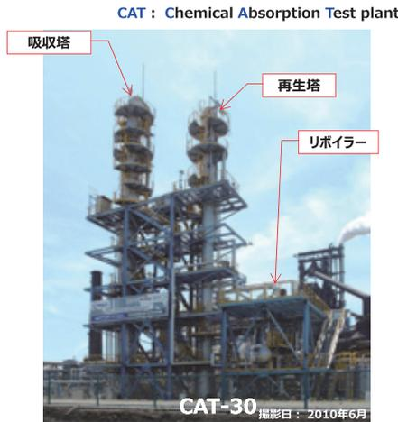
図2 COURSE50 Step1 実証試験設備の外観
