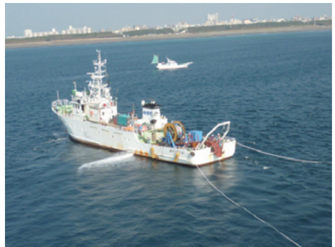
図6 常設OBC敷設作業
