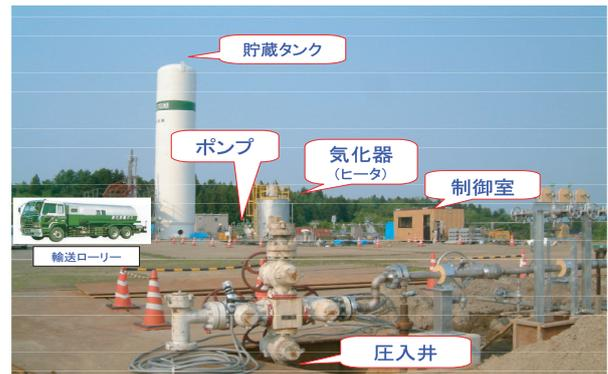
図2 CO<sub>2</sub> 地中貯留岩野原実証試験サイト
