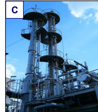
10 TPD松島パイロット試験(J-Power)
