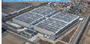
大口第2部品センター太陽光 水電解水素ステーションプロジェクト
