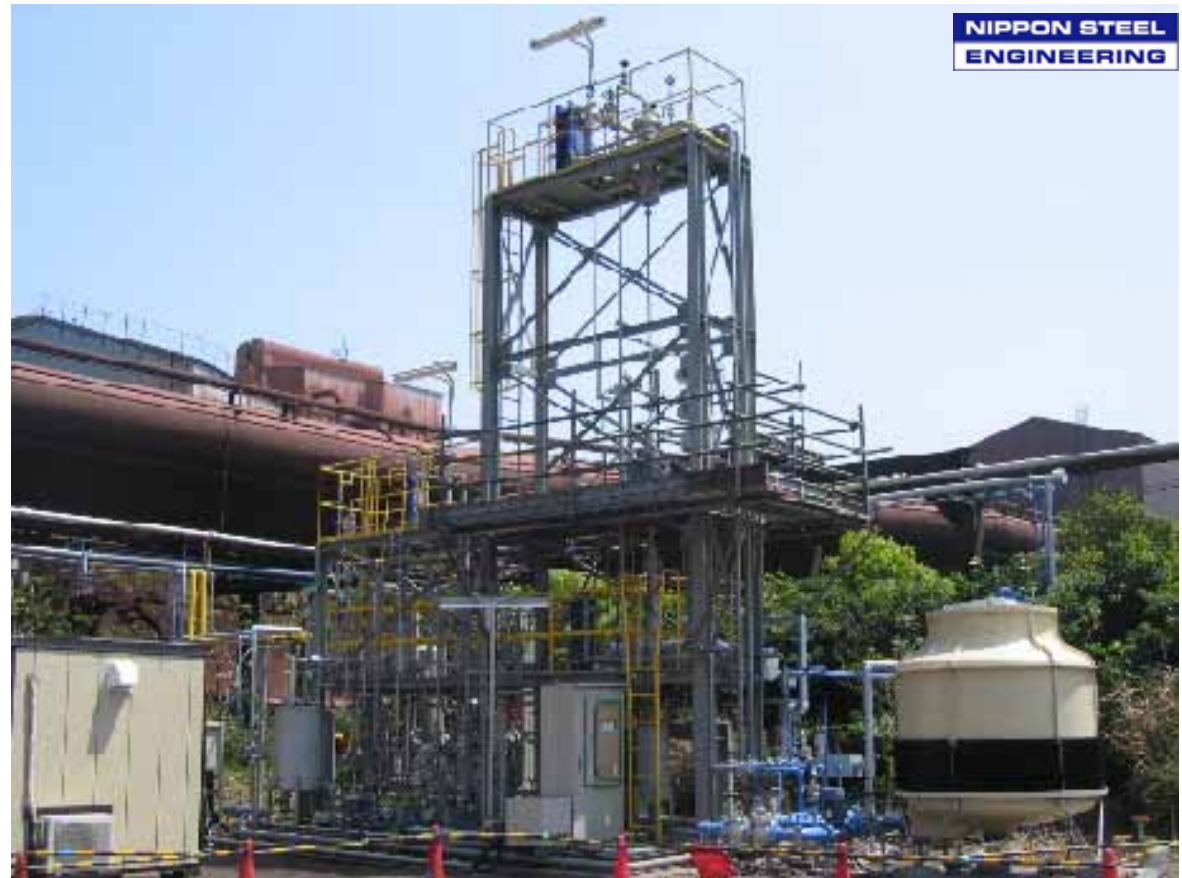
(新日本製鐵(株)君津製鉄所構内)
