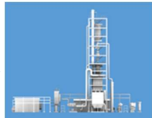
パイロットスケール試験設備 (川崎重工建設中) (40 ton-CO 2 /day) @ 関西電力(株)舞鶴発電所
