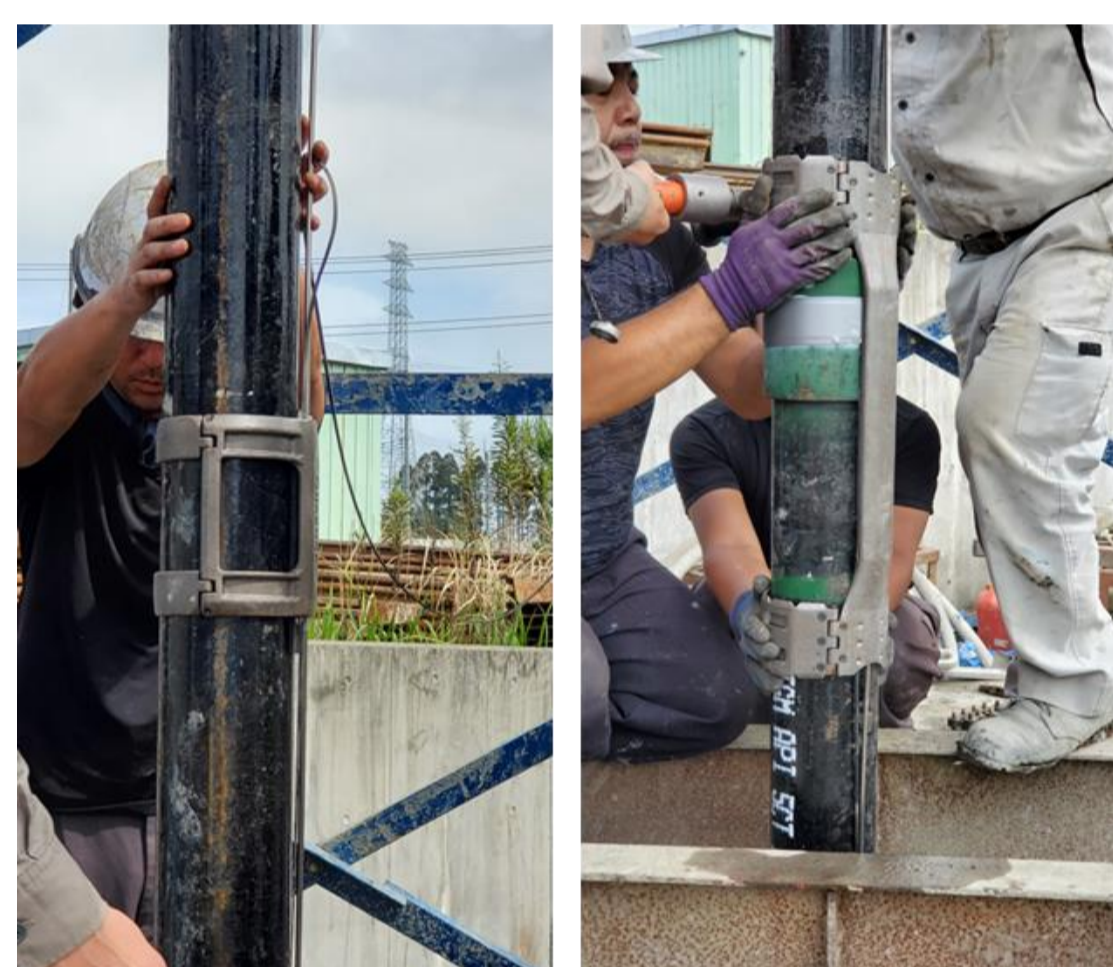
光ファイバーケーブルの取り付け
