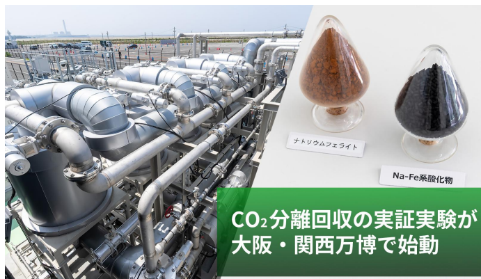
エア・ウォーターのCO 2 分離回収設備
