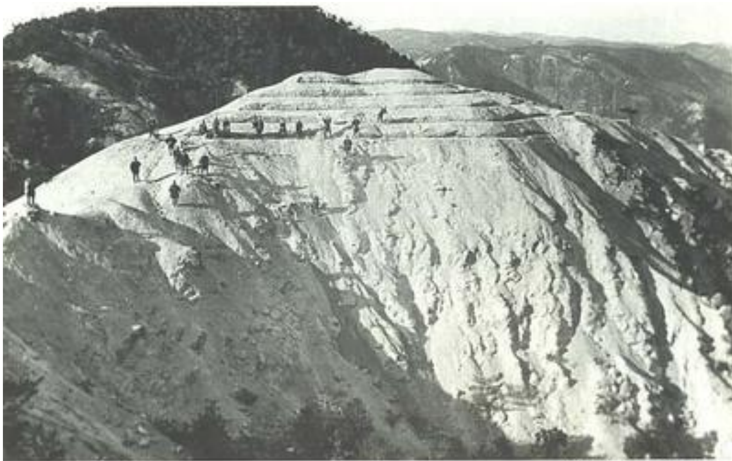
明治32年（施工中）
