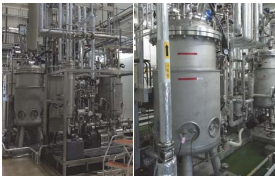
図7 フェノール製造パイロット設備
