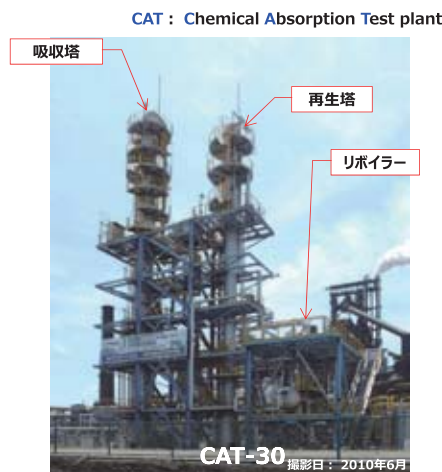
図2 COURSE50 Step1 実証試験設備の外観
