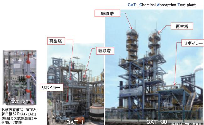
図3 試験設備の外観
