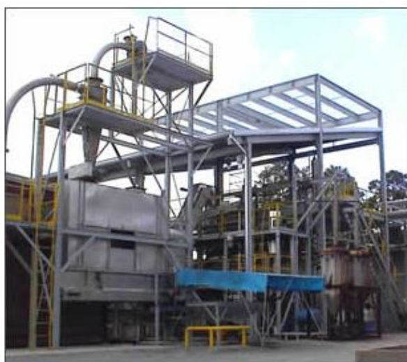
図 2.2-3 パイロットプラントの概要 82)
