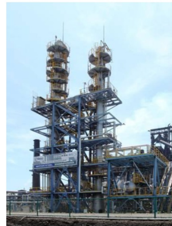
二酸化炭素回収 実証プラント
