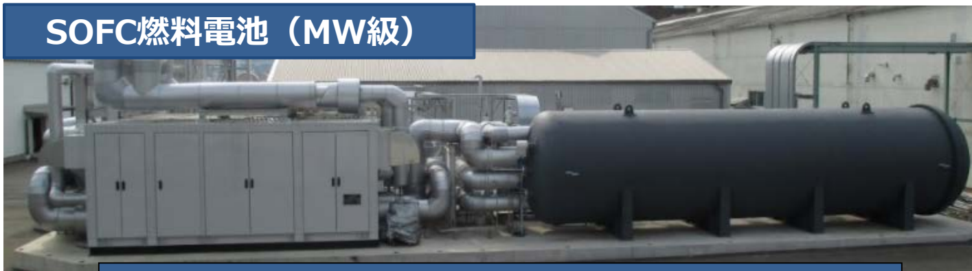
600kW級燃料電池モジュール (天然ガス燃料) :MHPS
