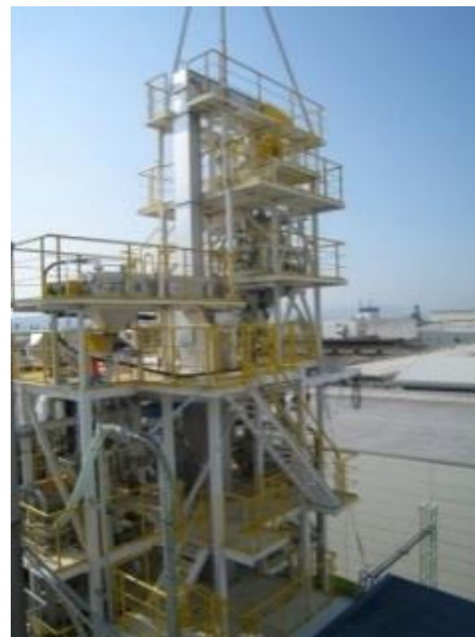
川崎重工業(株) KCC移動層 ベンチ試験装置
