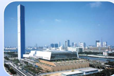
ごみ焼却発電施設
