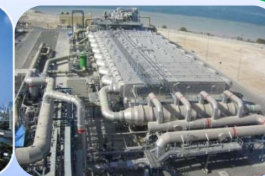
海水淡水化プラント
