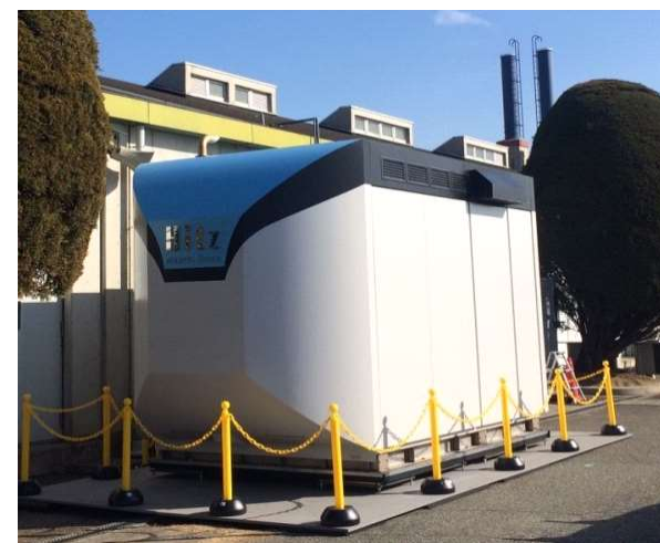
社外実証試験機設置状況 (於咲くやこの花館管理棟敷地内)
