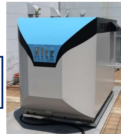
ORIST和泉センター 設置状況
