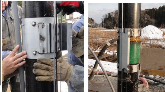
図-5 光ファイバーの設置概念図、ファイバー固定用クランプ、カップリングプロテクター
