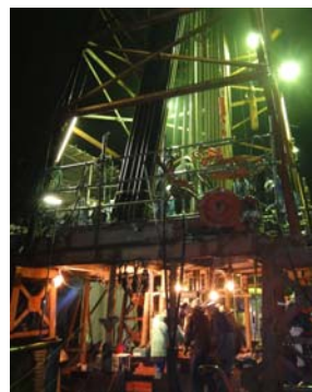
図-8 光ファイバー設置作業
