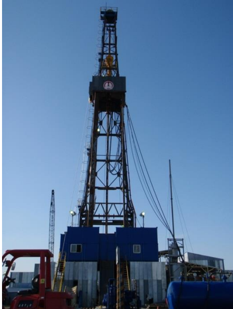
Rig: 48.5m high
