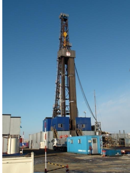
Rig: 30.2m high
