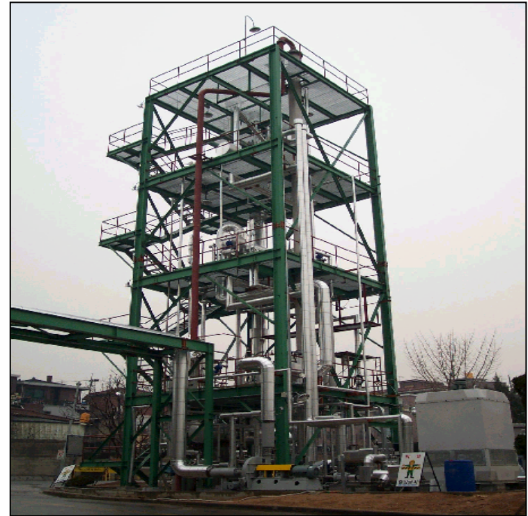
Test Bed of CO 2 Capture at Seoul LNG Cogeneration Plant, 2tCO 2 /d
